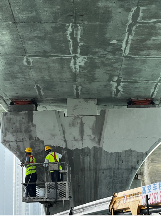
东南西环高速公路三窖立交混凝土防腐施工
