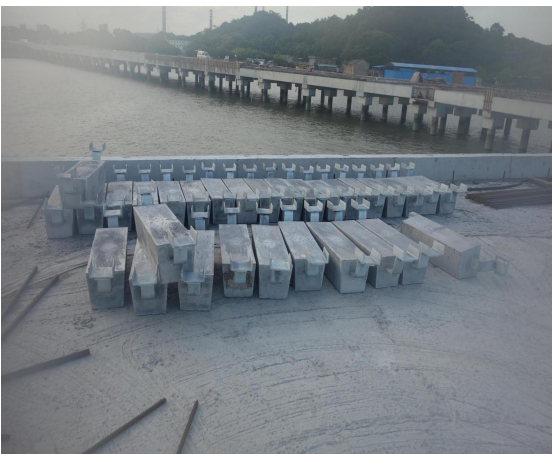
东莞虎门宏业货柜码头迁建 工程钢管桩牺牲阳极施工
