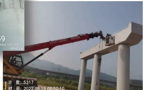
深汕TJ11长沙湾互通基层处 理及涂层防腐
