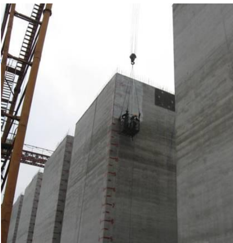
海南雅居乐陵水县清水湾游艇码头高空作业
