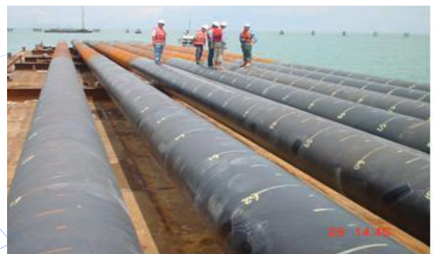
珠海港高栏港区集装箱码头钢管桩防腐工程
