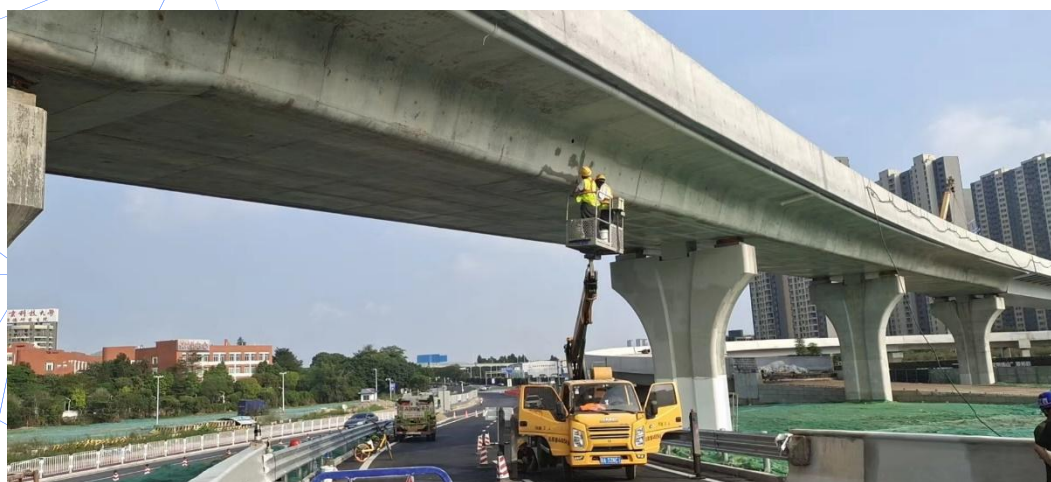
顺德碧桂路立交桥防腐涂层施工
