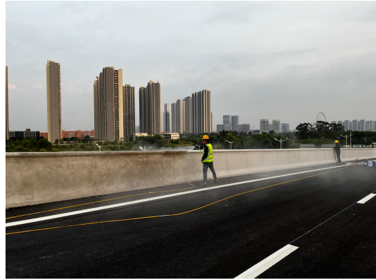
顺德碧桂路立交桥喷涂底漆
