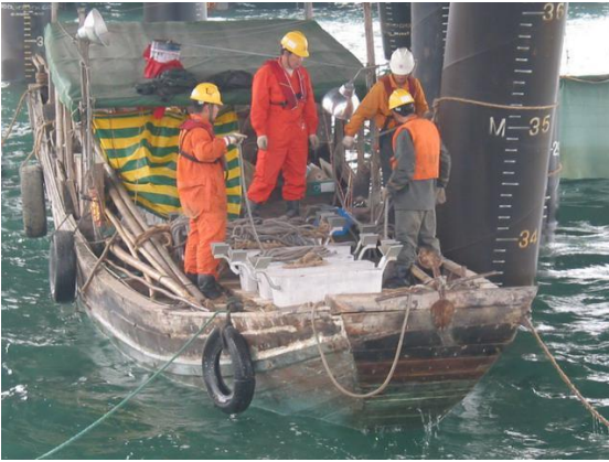
蛇口太子湾邮轮母港工程 码头钢桩牺牲阳极施工
