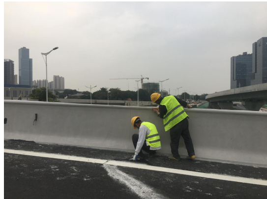
顺德碧桂路立交桥防腐涂层施工
