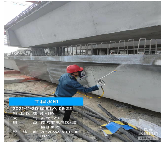
茂名港吉达港区东作业区管廊一期工程防腐喷涂
