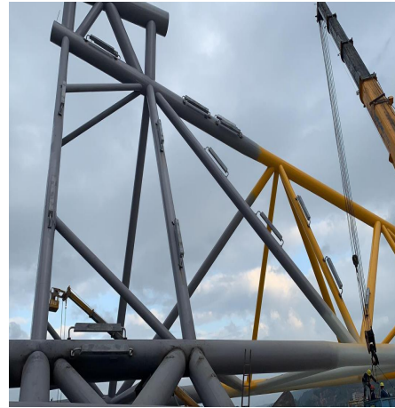
深圳港妈湾港码头水工 工程牺牲阳极施工
