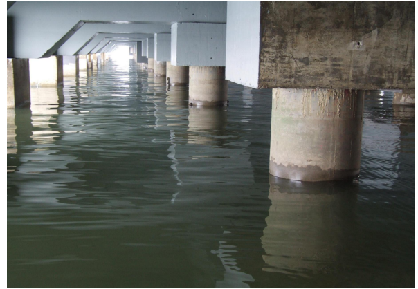
深圳赤湾港区突堤多用途泊位混凝土防腐
