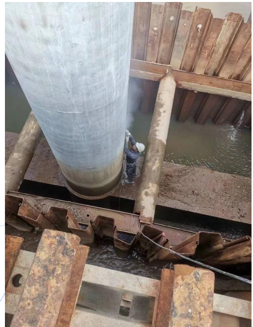
中山港中山港区长大路桥公司 码头一期工程防腐（海上桥墩 喷涂底漆作业）
