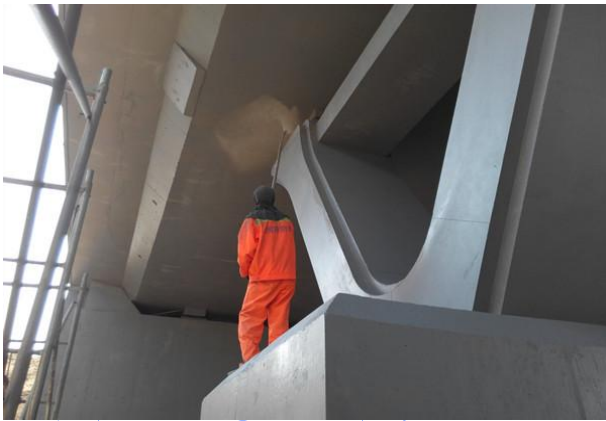
东海岛石化产业园区港南大道混凝土防腐
