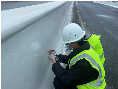
深圳湾滨海工程涂层干膜厚度检测
