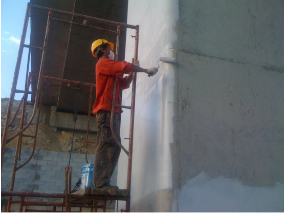
阳江港#J13~#J14码头工程混凝土防腐施工
