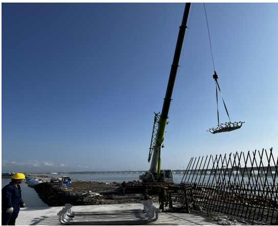
广州港新沙港区泊位工程牺牲 阳极施工
