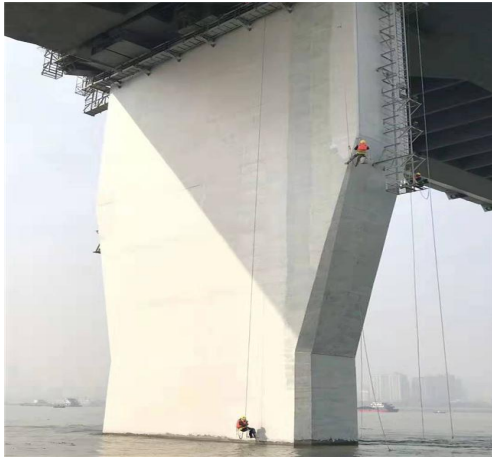
深汕TJ6高速防腐施工
