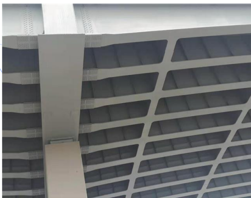
深中通道防腐工程
