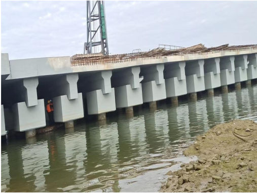
阳江港 #J11~#J12泊位工程混凝土防腐施工
