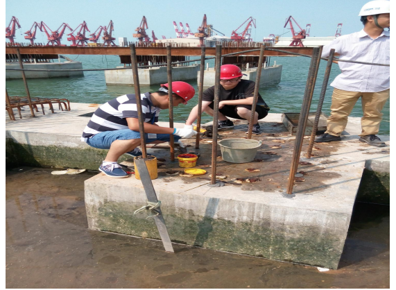
蛇口邮轮码头植筋拉拔力检测
