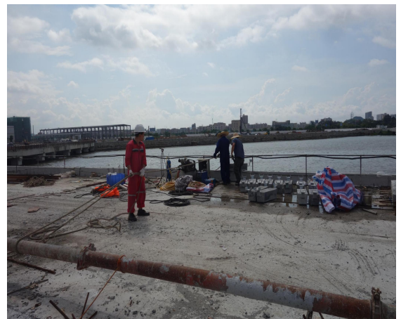
虎门港沙田港区西大坦作业区 驳船码头钢板桩牺牲阳极施工
