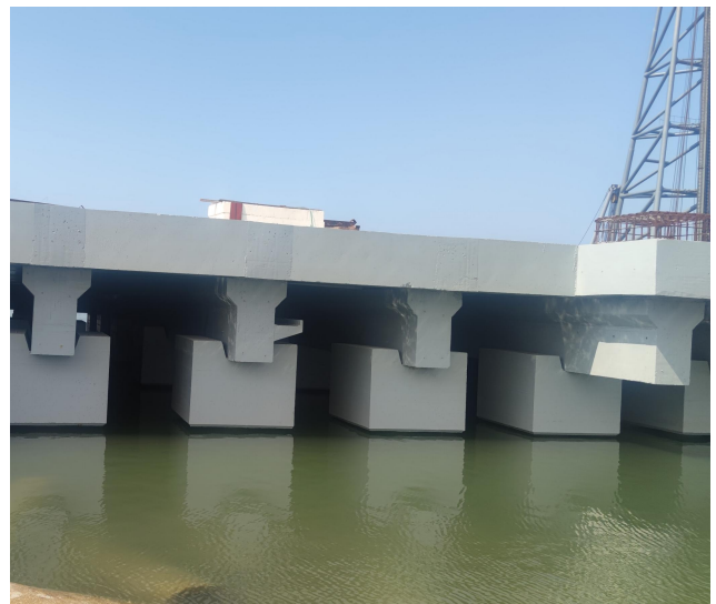
硅烷浸渍+防腐涂层码头效果
