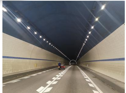
东海岛石化产业园区 港南大道隧道
