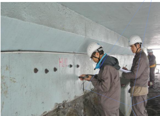
深圳液化天然气项目码头涂层粘结力检测
