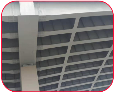
桥梁防腐涂装
