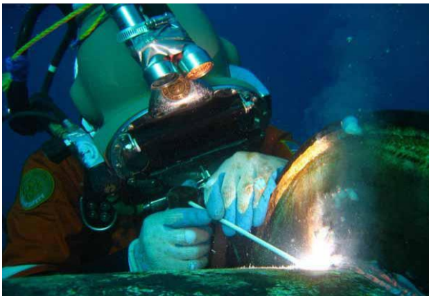
水下焊接作业
