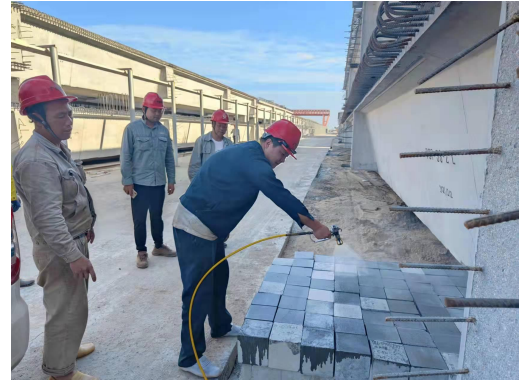
阳江港 #J11~#J12泊位工程混凝土防腐施工
