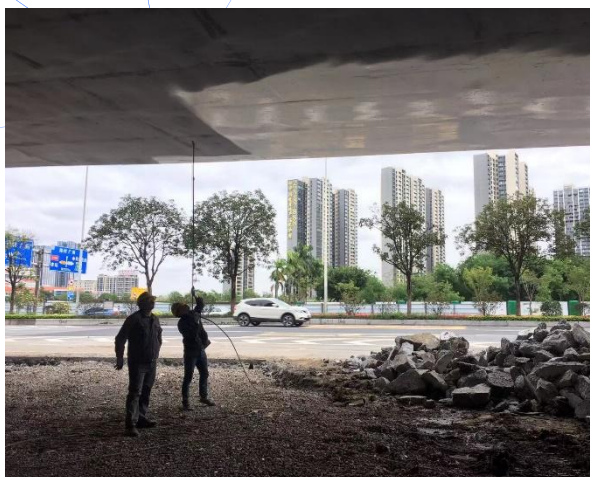
桥梁现场施工
