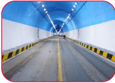
市政及隧道防腐
